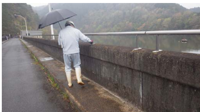
ダム堤頂道路点検状況
