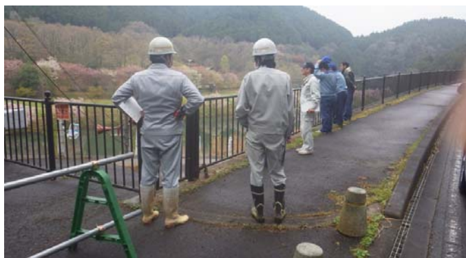
貯水池周辺(子供のもり公園)点検状況
